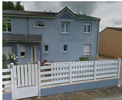
Clôture à claire-voie
